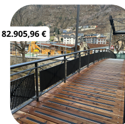
Rehabilitació de la pasarel·la de la Mola_ en curs
