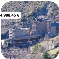
Rehabilitació del viaducte d'Hort de Godí
